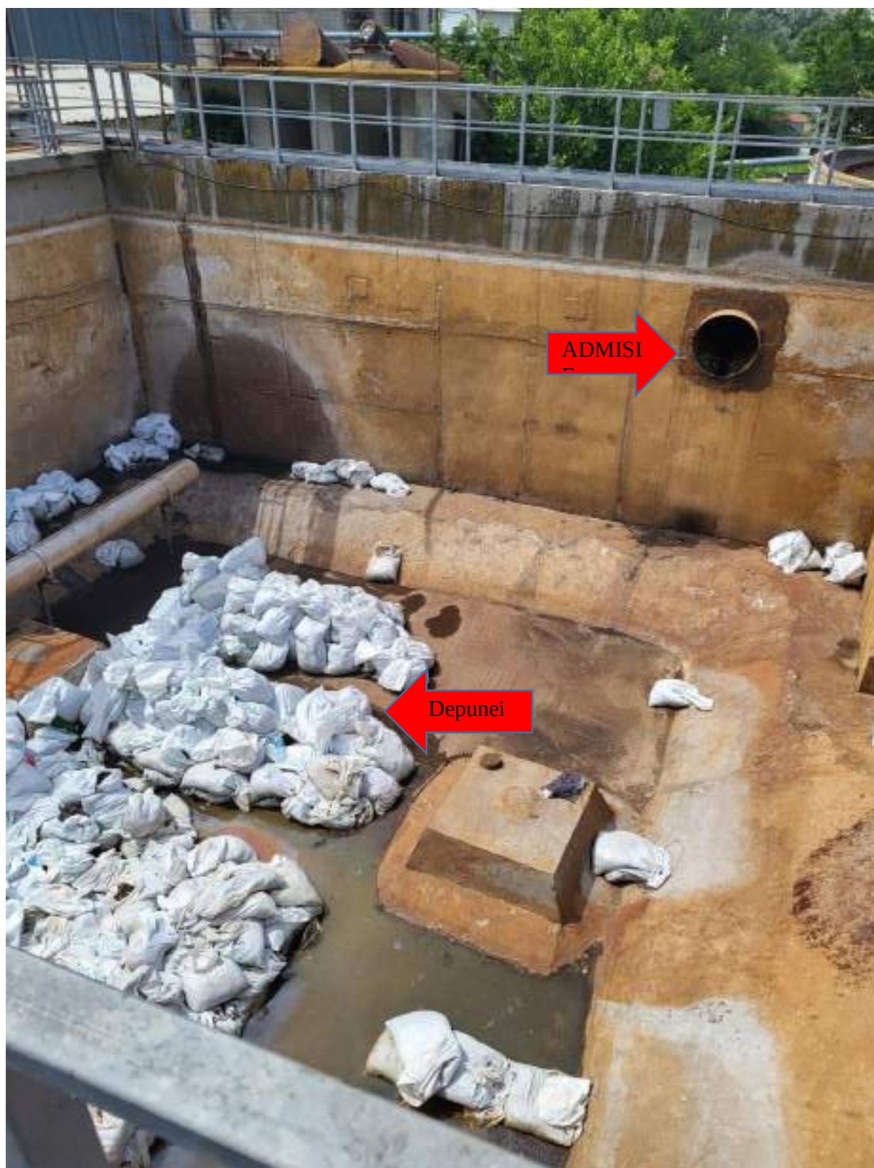
Imagine 1 – Bazin namol activat – cuva 1
