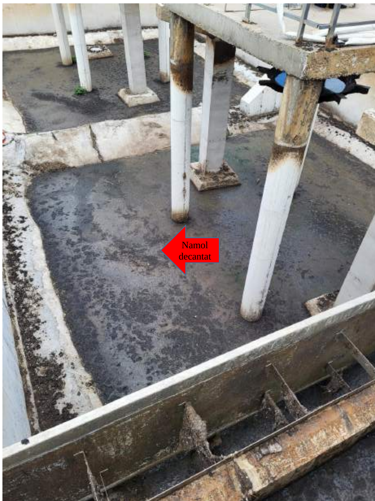
Imagine 4 – Bazin namol activat – cuvele 4 si 5
