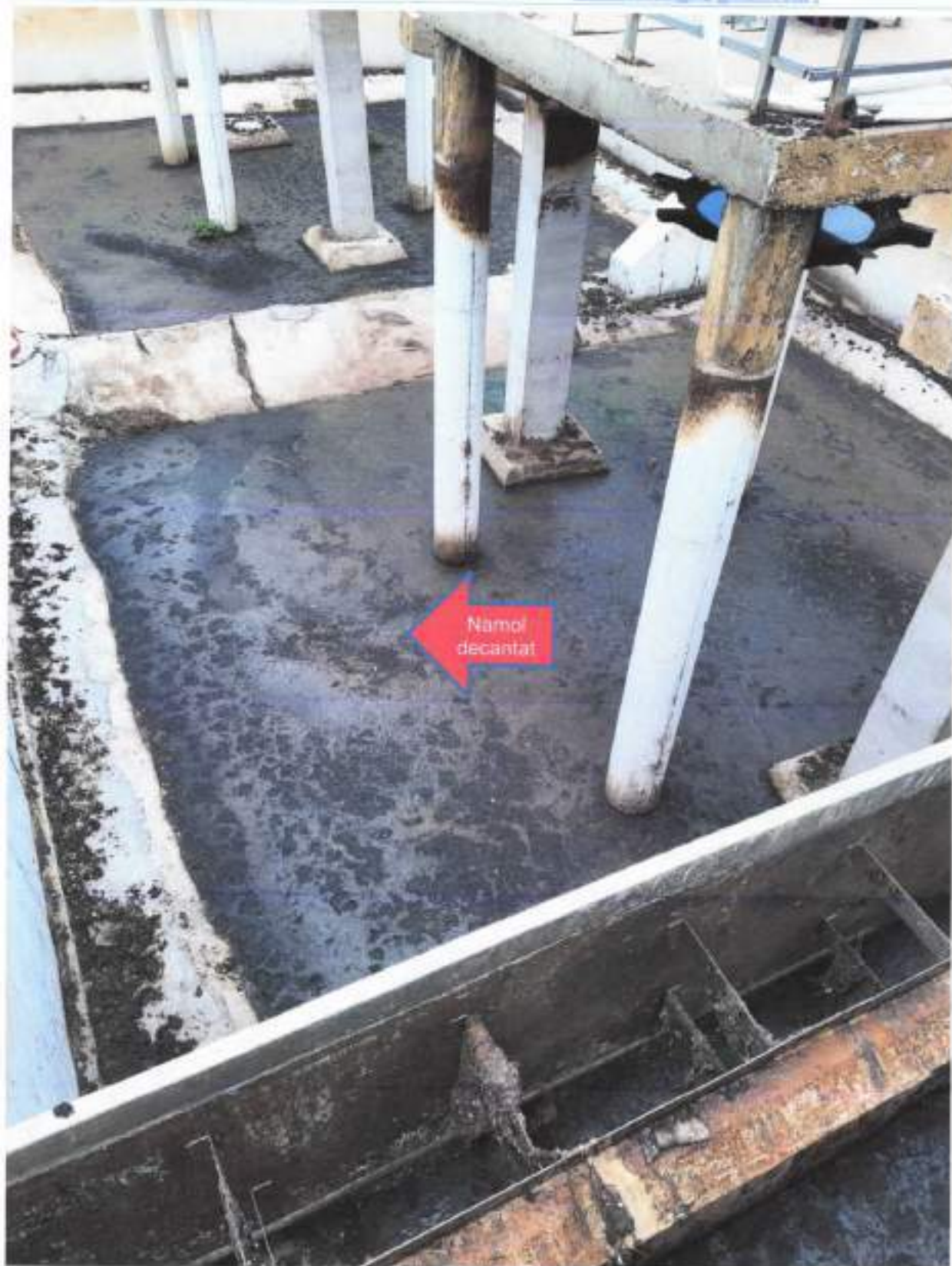
Imagine 4 – Bazin namol activat – cuvele 4 si 5
