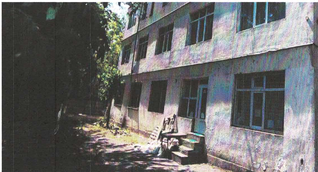
Foto 10 – Aspecte exterioare: Degradari la nivelul trotuarelor si scarilor de acces
