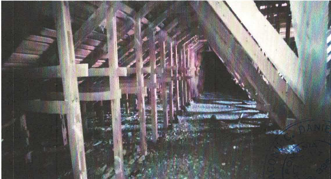
Foto 22 – Aspecte interioare: Alcatuire sarpanta
