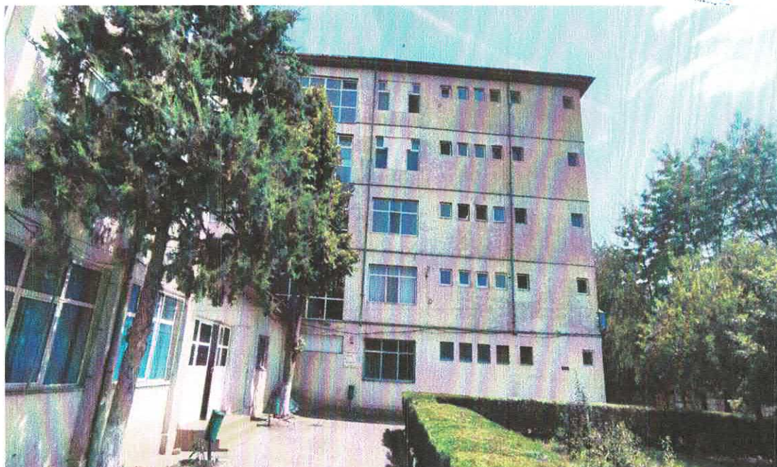
Foto 02 – Aspecte exterioare: Fatada principala (vedere partiala – dreapta)
