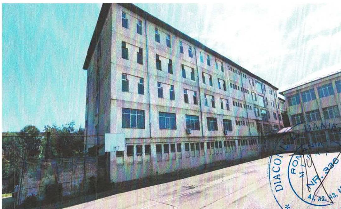
Foto 01 – Aspecte exterioare: Fatada principala (vedere partiala - stanga)
