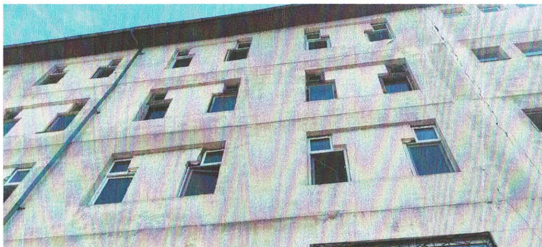
Foto 08 – Aspecte exterioare: Degradari la nivelul tamplariei etajului 3
