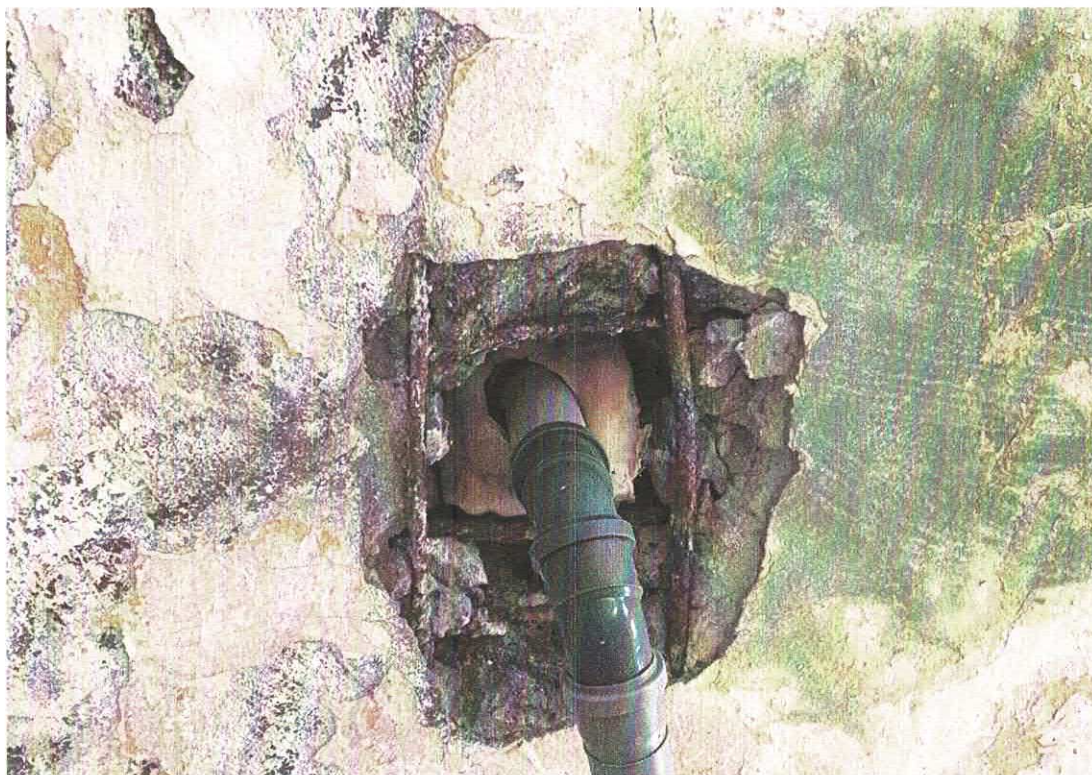
Foto 19 – Aspecte interioare: Aspect armatura placa
