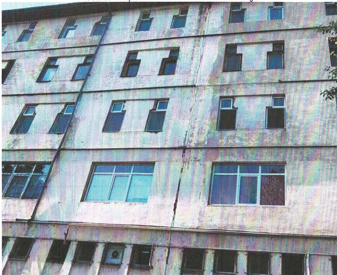
Foto 06 – Aspecte exterioare: Degradari la nivelul fatadelor (desprinderi de tencuiala, crapaturi, pete)
