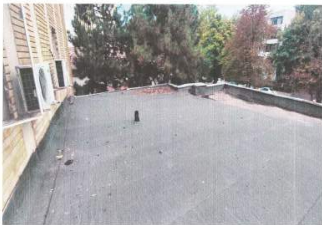
Foto 14 - Aspecte exterioare: Acoperis terasa (degradari locale)
