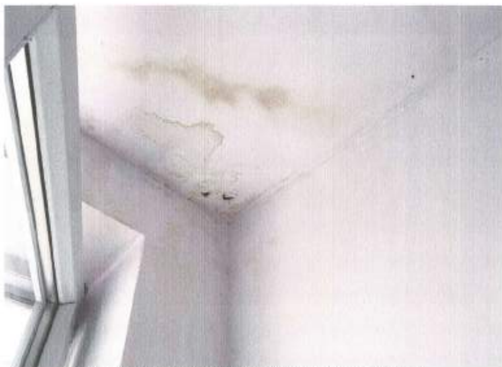
Foto 09 – Aspecte interioare: Pete și infiltrații locale la nivelul tavanului
