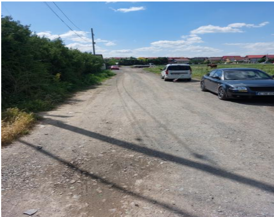
Foto: Extindere rețea de gaz natural strada Vidin
