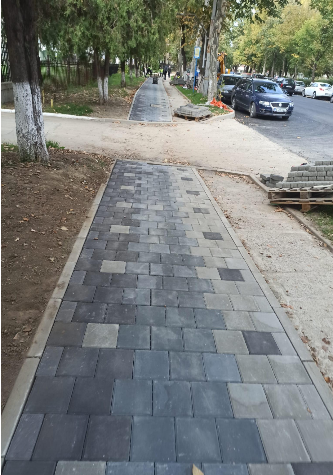
Foto : Reabilitare cai de rulare Slobozia
