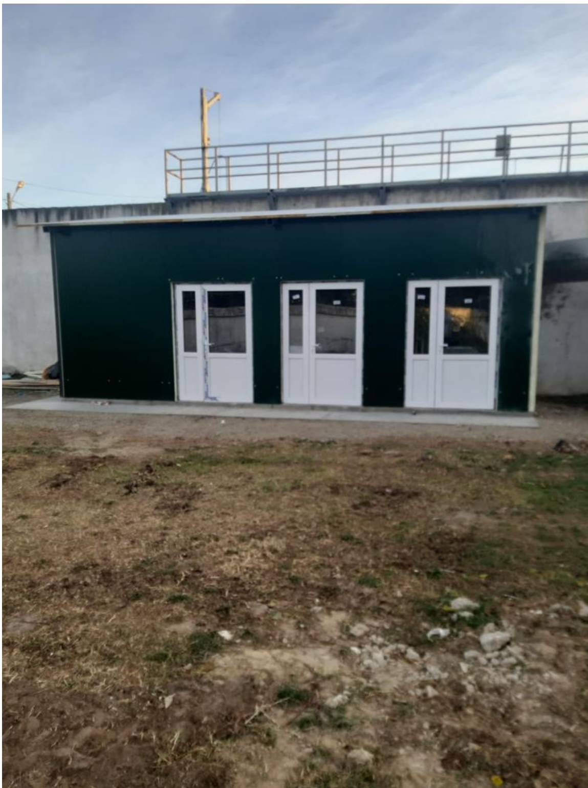
Foto -Retehnologizare treaptă aerare Stație de Epurare Slobozia
